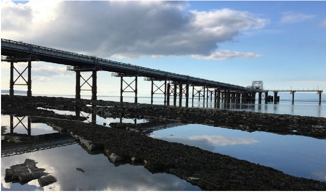
Fot. 5 | Przykład pomostu na palach. Elektrownia jądrowa Hinkley Point C, Anglia. Źródło: Zasoby własne.
