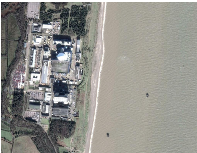
Fot. 3 | Elektrownia jądrowa w Wielkiej Brytanii, Sizewell. Źródło: Google Earth.
