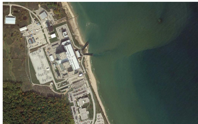
Fot. 2 | Elektrownia jądrowa w Point Beach, USA. Źródło: Google Earth.
